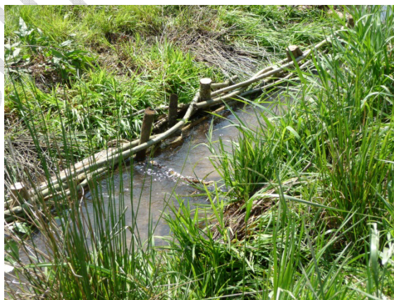
Stabilisation des berges par tressage réalisé sur le ruisseau de l'Heymonrupt (Aappma Esch)
