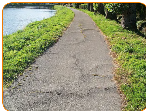
Remontées racinaires sur le revêtement en enrobé du Canal de Nantes à Brest
