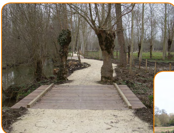
Marais poitevin, un exemple de resserrement de la voie, pour maintenir en place les arbres.
