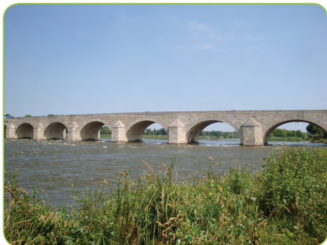
Pont de Beaugency
